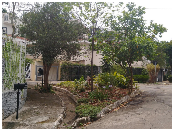
Figura 3 – Jardim de chuva na Vila Jataí, em São Paulo (SP)
