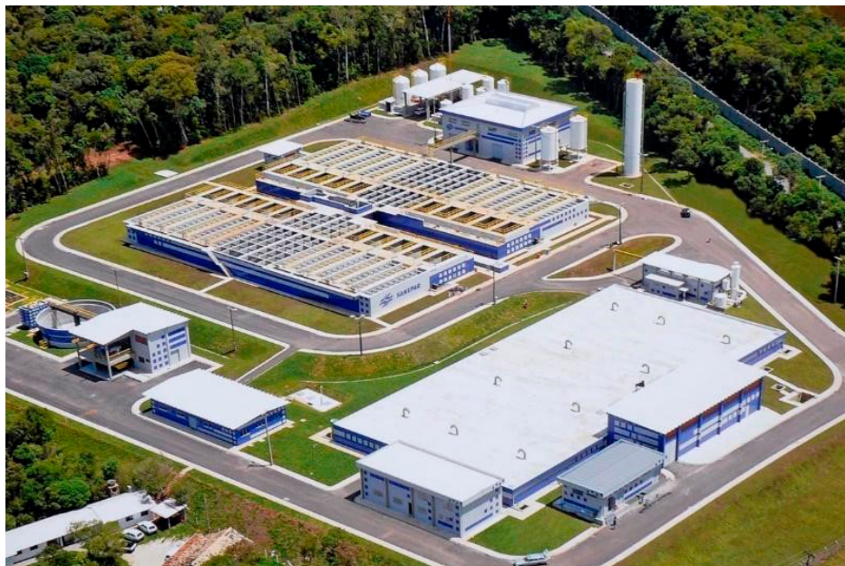
Figura 1 – Imagem da Estação de Tratamento de Água Miringuava, em Barro Preto, São José dos Pinhais (PR)
