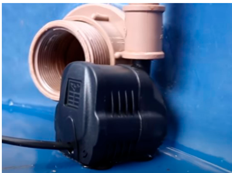
Figura 5 – Demonstração da bomba instalada no tanque dos peixes
