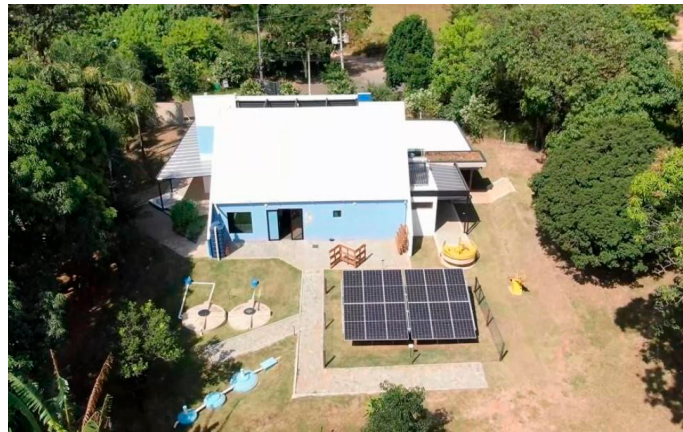
Figura 2 – Vista aérea da parte externa da Casa Mais Sustentável
