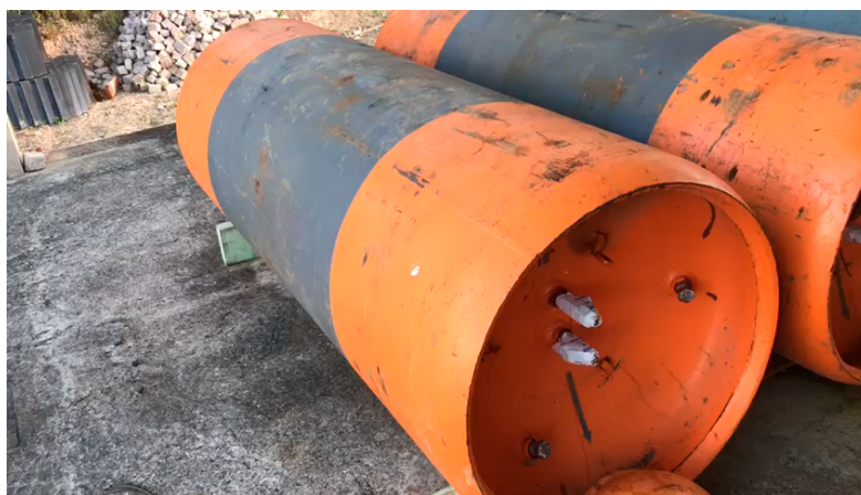
Figura 7 – Cilindros de cloro gasoso (900 kg) da ETA
